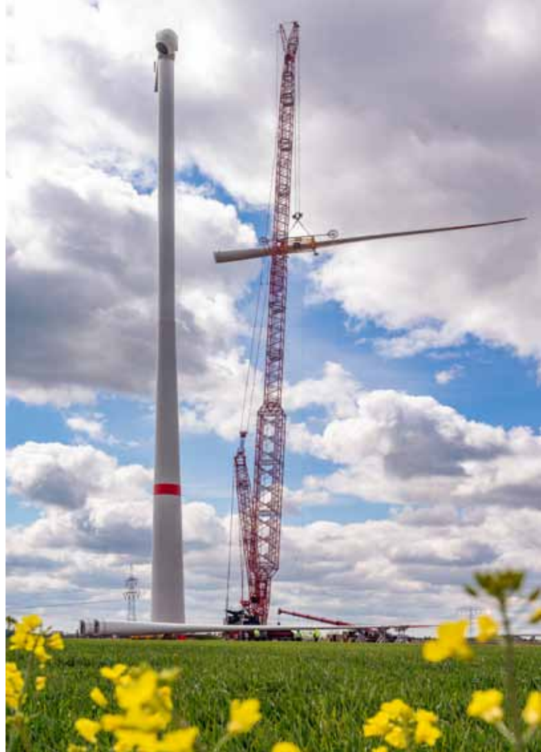
Montage einer Windenergieanlage im EBL.
